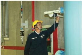
段绍荣在焊接现场工作
